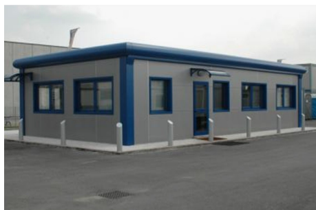
Aplicación especial a pedido en 1 nivel
